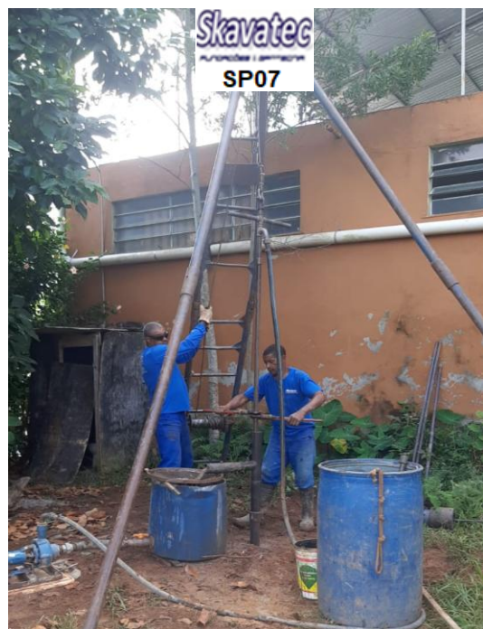
Foto 7 - Equipamento de Sondagem em Operação
