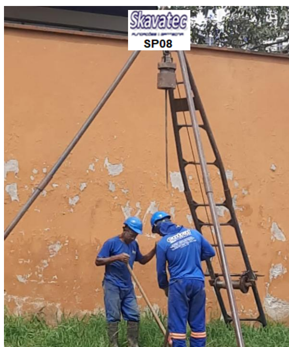
Foto 8 - Equipamento de Sondagem em Operação
