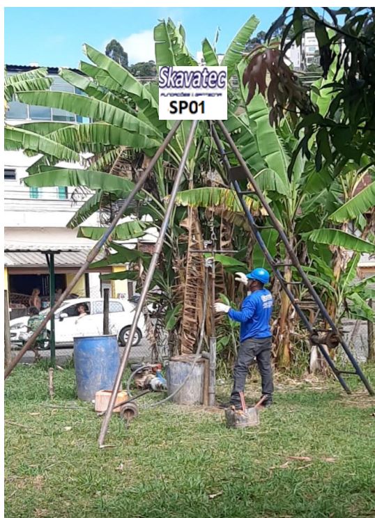
Foto 1 - Equipamento de Sondagem em Operação
